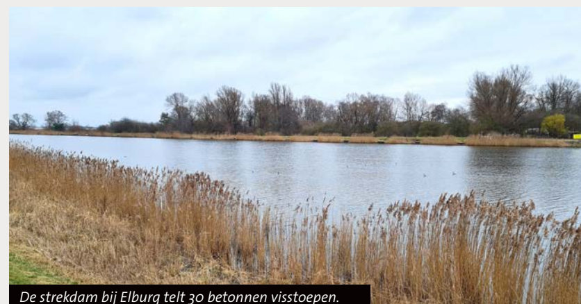
De strekdam bij Elburg telt 30 betonnen visstoepen.
